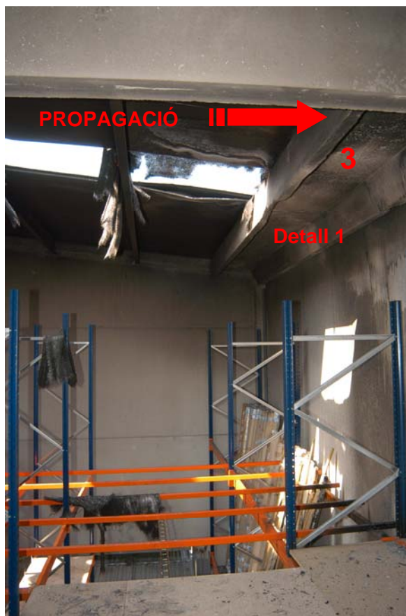
Foto 2: Vista interior inutilització franja tallafocs
